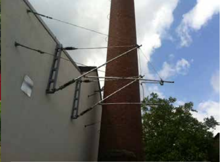
Bild oben: Oberleitungsattrappe der Deutschen Bahn
